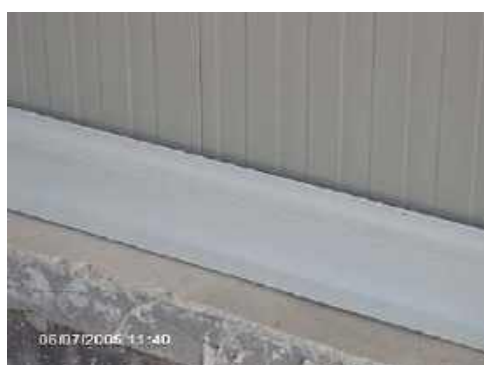
11.-COLOCACION REMATE SOBRE LANA MINERAL
