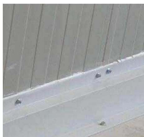
14.-ESTADO FINAL DE REMATE SELLADO
