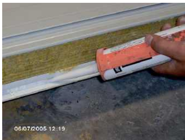
4.-APLICACIÓN DE MASILLA IGNIFUGA EN JUNTA
