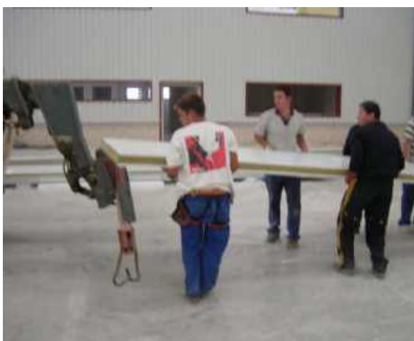
5.-POSICIONAMIENTO DE PANEL SOBRE RODILLO
