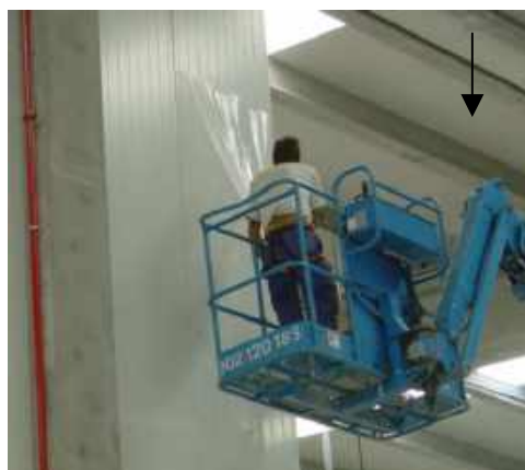
9.-PELADO DE FILM CARA INTERIOR
