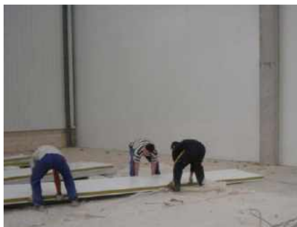
2.-POSICIONAMIENTO DEL PANEL A PIE DE PAÑO
