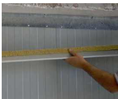
11.-COLOCACION REMATE SOBRE LANA MINERAL
